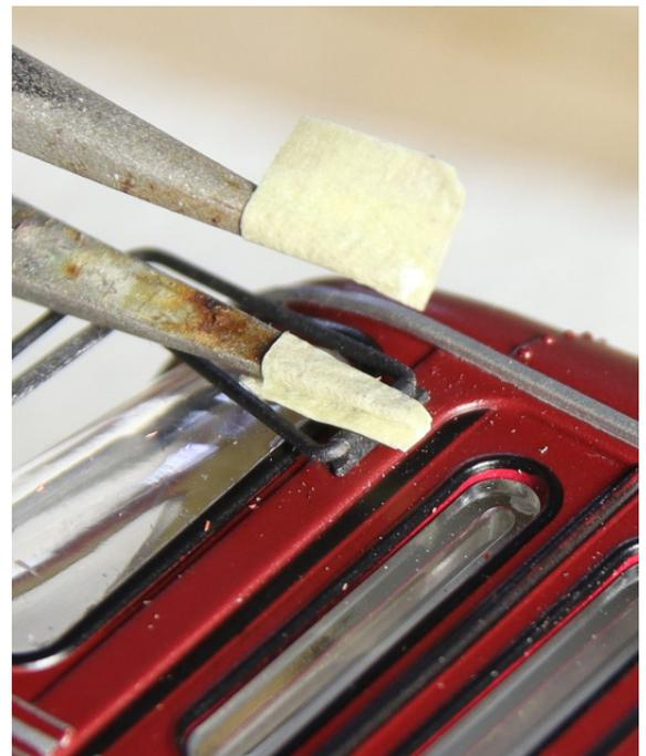
Pinzette mit Tesakrepp umwickeln und die Zapfen in die Wand drücken. Mit einem der Pinzettenschenkel nachdrücken. Kleben ist nicht erforderlich.
